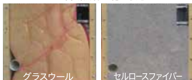
壁内断熱材の施工状態
